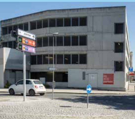
Auf einen Blick: das neue Parkleitsystem zeigt die verfügbaren Parkplätze live an, wie hier beim Parkdeck SÜD.
