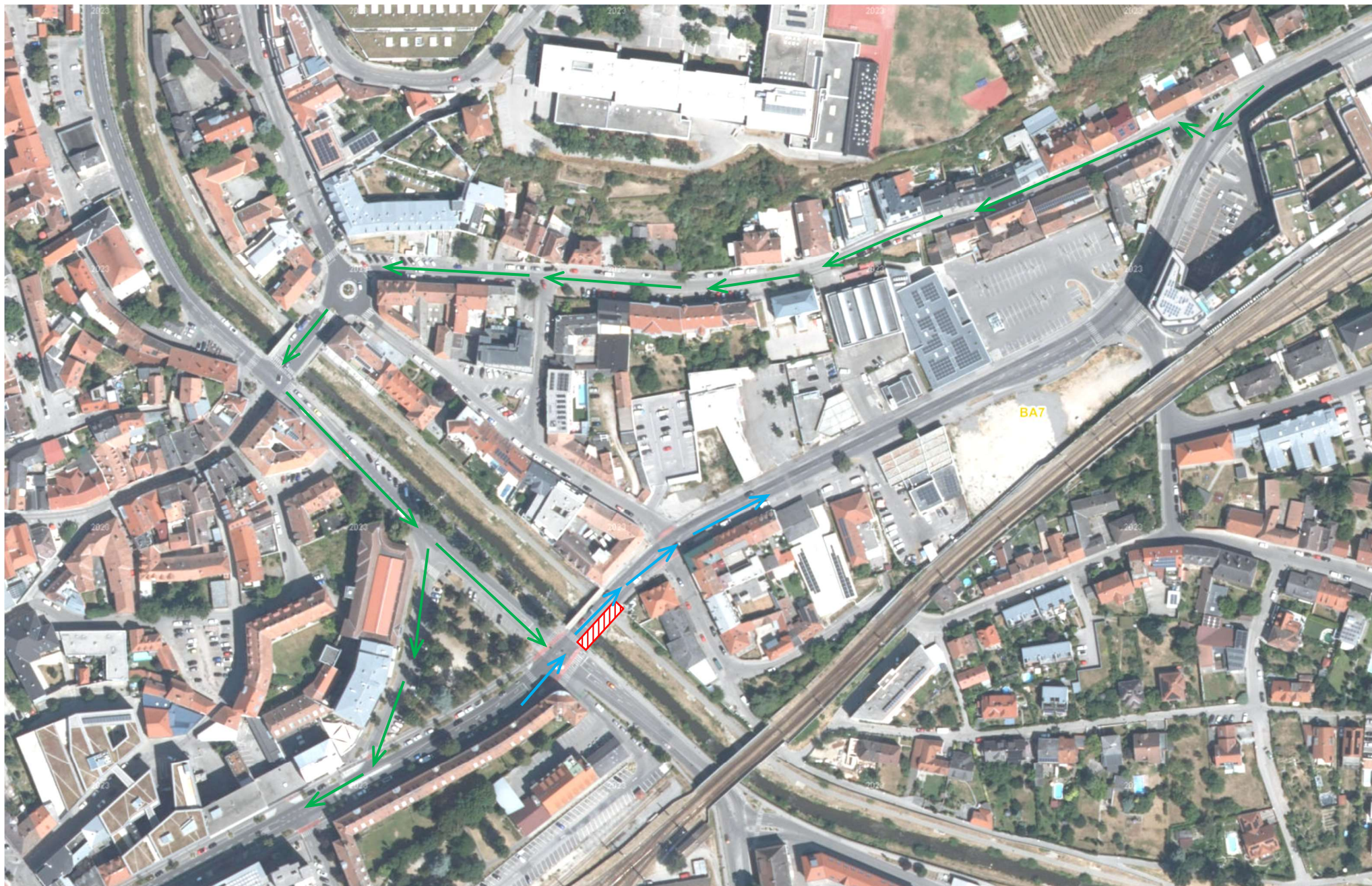
PKW, halbseitige Sperre Brücke Süd:
