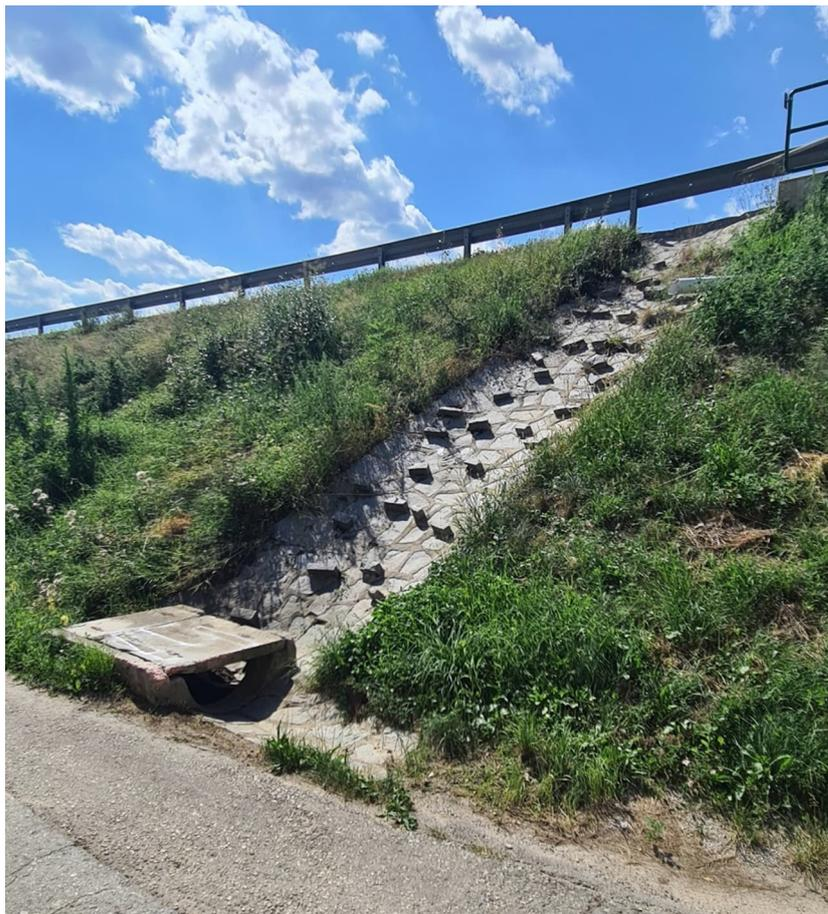
**Abbildung 3-3: Blick Richtung Südwesten, Entwässerung B 37, bestehender Einlaufschacht**
