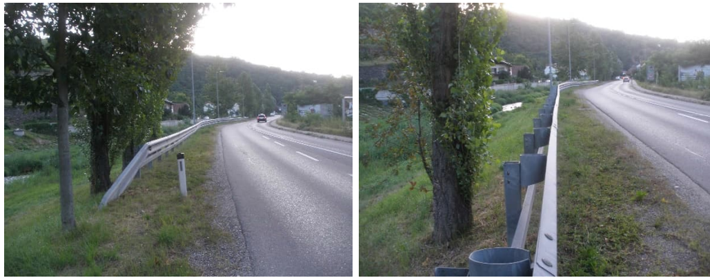
Abbildung 7-7: L73 Bereich Linksabbiegespur zwischen den Häusern B und C
