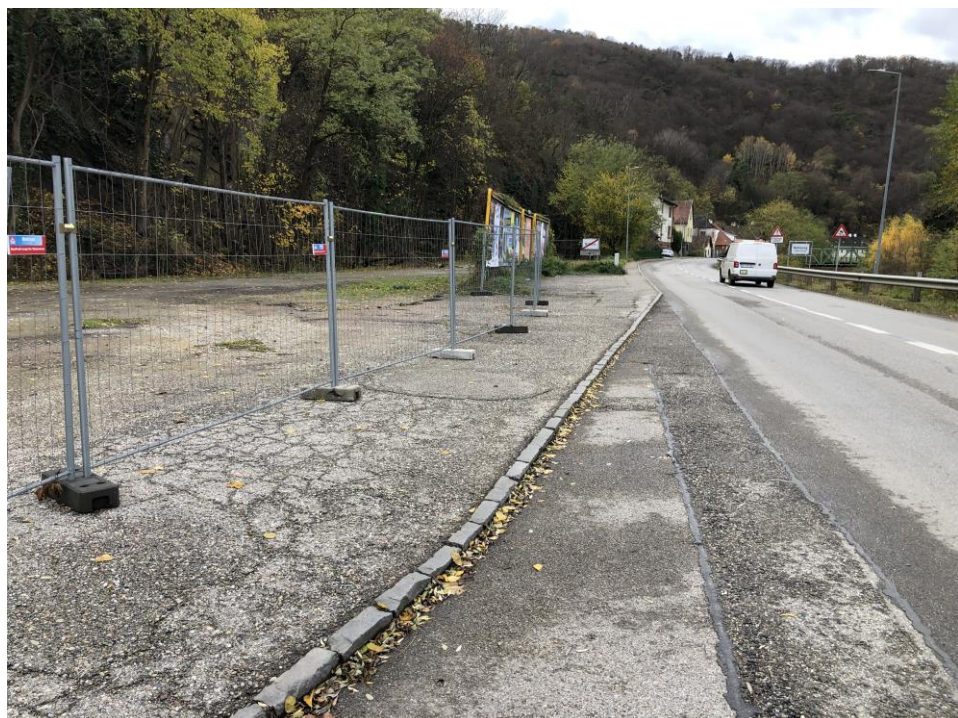
Standort: L73, bauplatzseitig Blickrichtung: stadtauswärts, Bereich dzt. Linksabbieger, Detail
