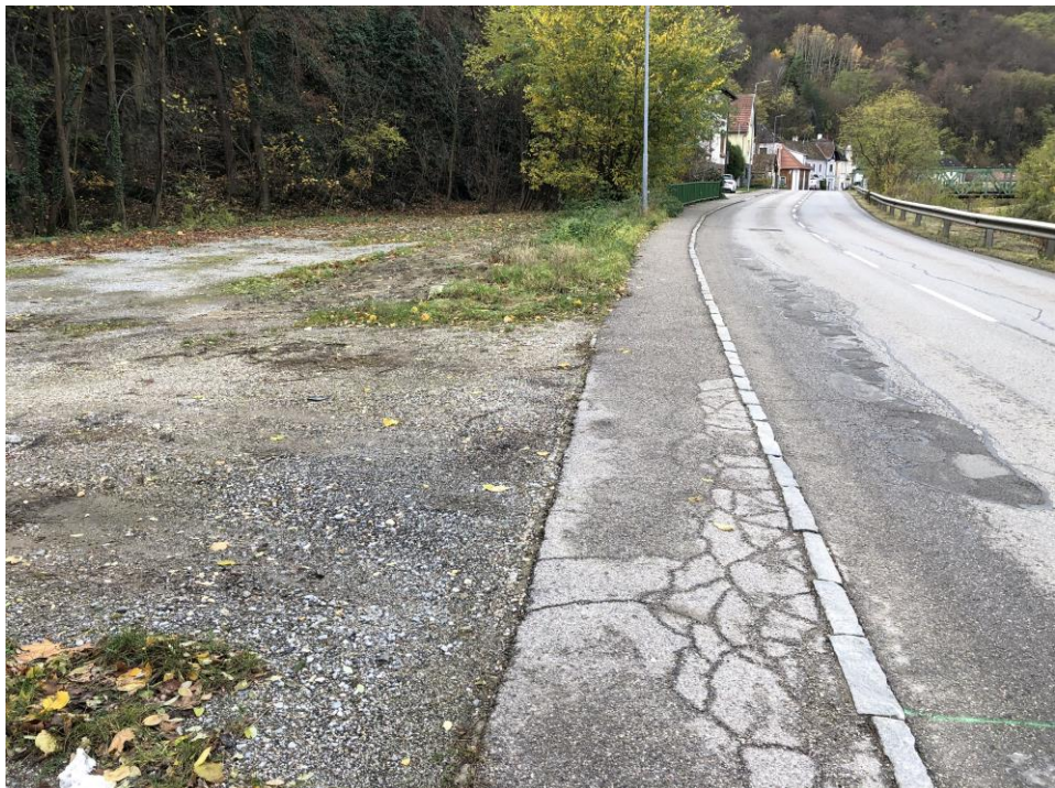
Standort: L73, bauplatzseiteig Blickrichtung: stadtauswärts, Bauplatzende
