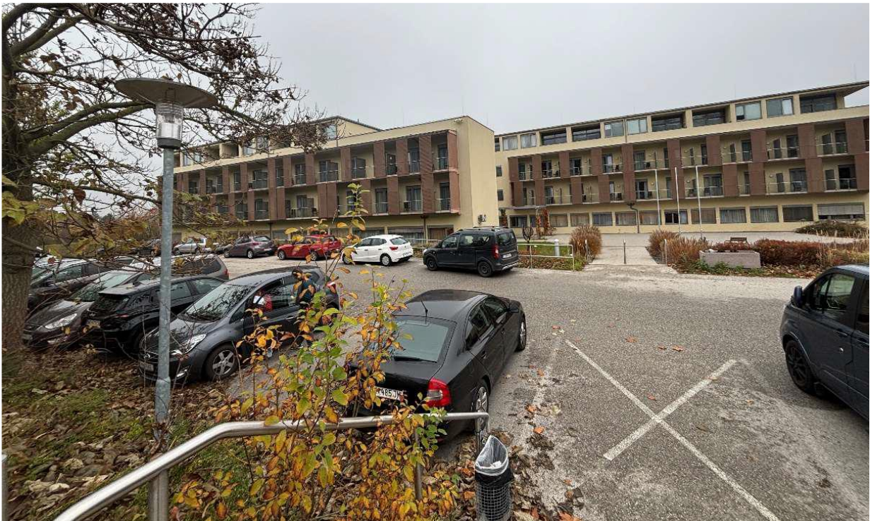
Abbildung 6: Blick vom Parkplatz auf die geplanten Erweiterungsfläche im Südwesten des Gebäudes (Aufnahme Architekturbüro DI in Dr. in techn. Andrea Redi)
