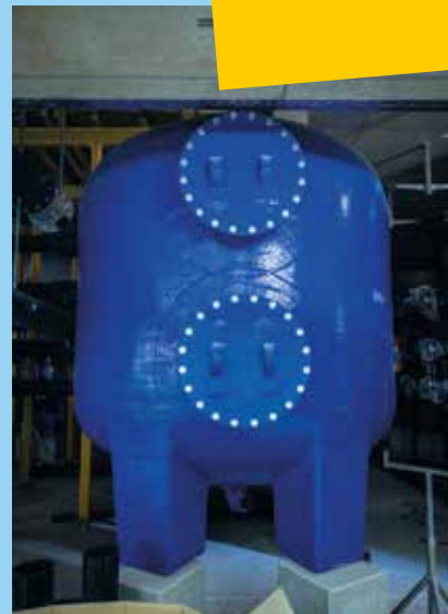
Riesige Reinigungsfilter für die Schwimmbecken: Die Badewasser- und Haustechnik wird bereits installiert. So hält der straffe Zeitplan.
