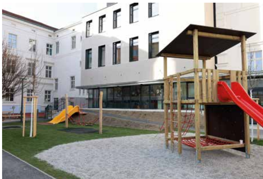
Die Kinder gelangen durch den in den Innenhof verlegten Zugang geschützter zur Schule.
